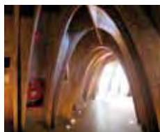
La Pedrera (Barcelona)
